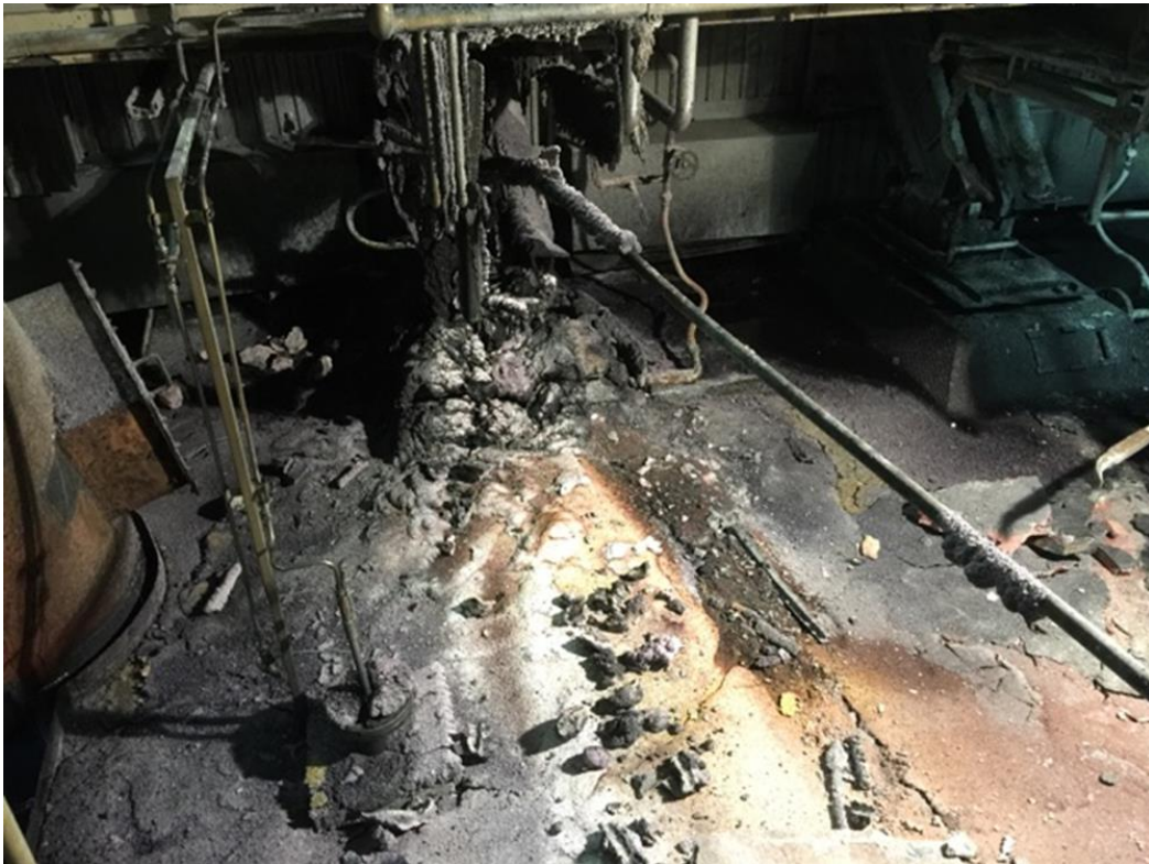
Bild: Efter löprännehändelse i MetsäBoard Husum, sodapanna 6
