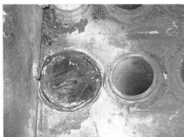
Bild 5: Täckbricka lagd invändigt i dom ovanpå tubhål.
