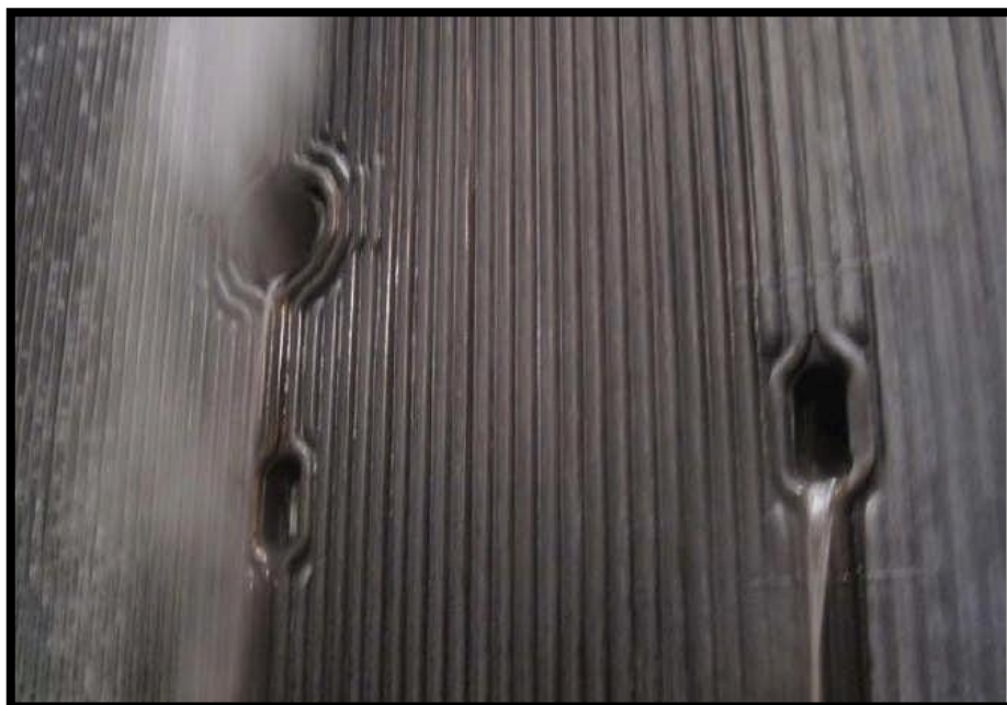
Bild: Det rinner vatten från starkgasbrännaröppningen samt från en sekundärluftport
