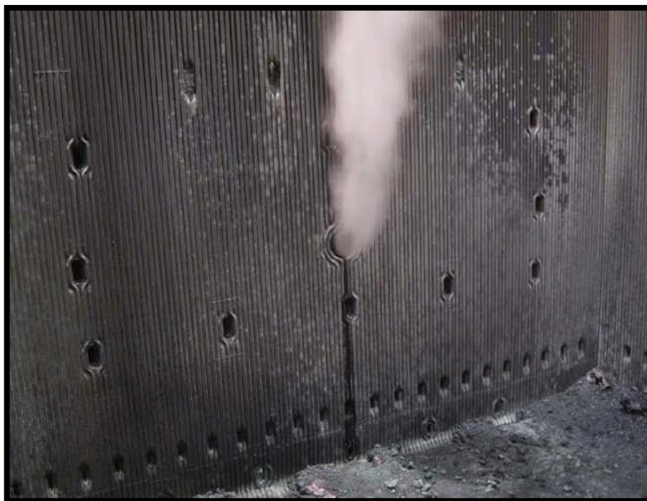
Bild: Det ångar kraftigt från starkgasbrännaröppningen
