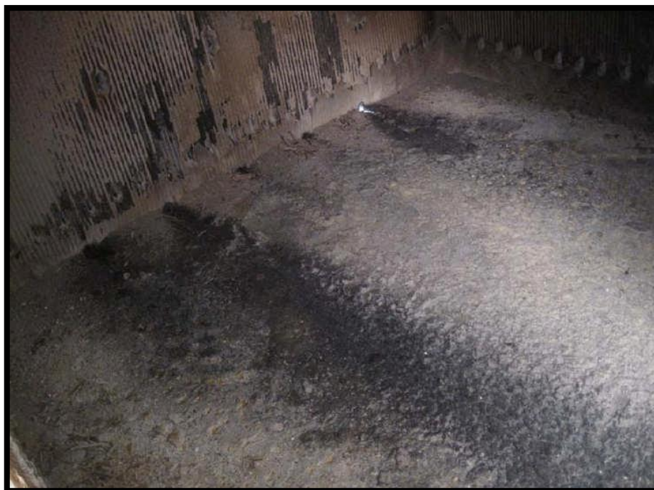
Bild: Bådden var efter 24 h avsvälning helt plan
