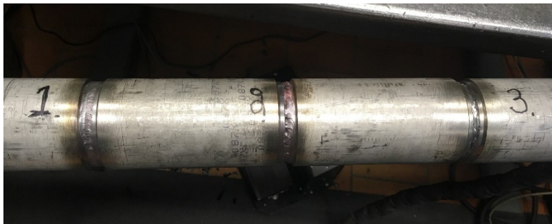
Figur 4. Bild på teströr 2 under pågående svetsning, svets nr 1 efter rotsträng och 2 fyllnadssträngar, svets 2 efter rotsträng och en fyllnadssträng, svets 3 efter bara rotsträngen.
