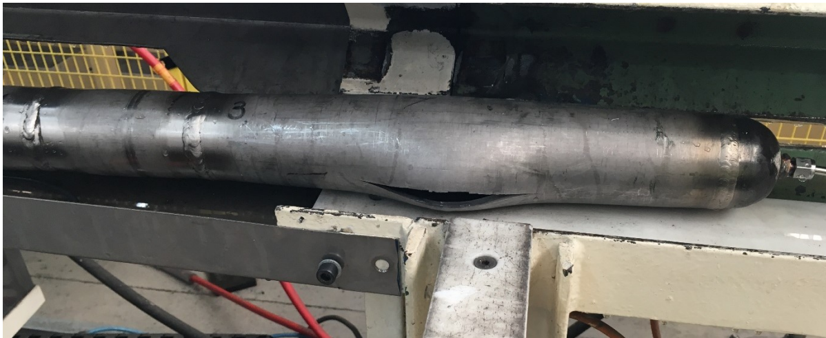
Figur 9. Längsgående spricka i röret.
